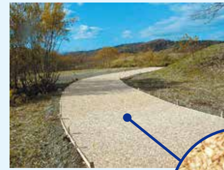
遊歩道(ウッドチップ施工)
